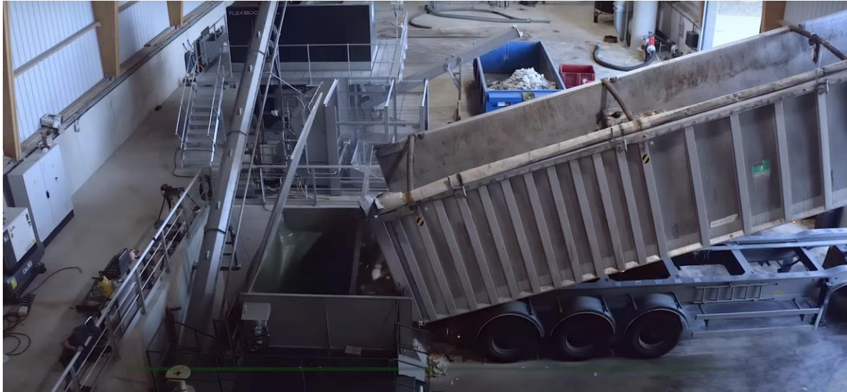
Figure 4: Exemple d'une fosse enterrée qui positionne la trémie
